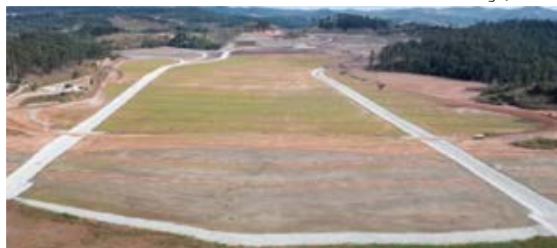
O Dique 2, do Sistema Pontal, em Itabira, é uma das barragens já descaracterizadas
