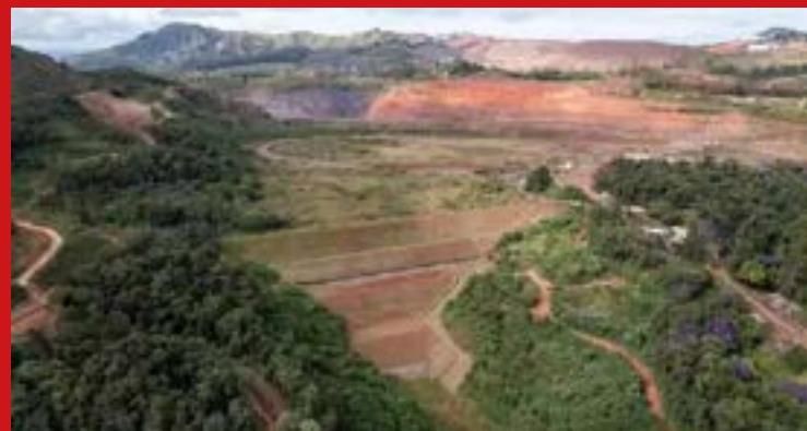
Barragem Grupo, localizada na Mina Fábrica, em Ouro Preto
