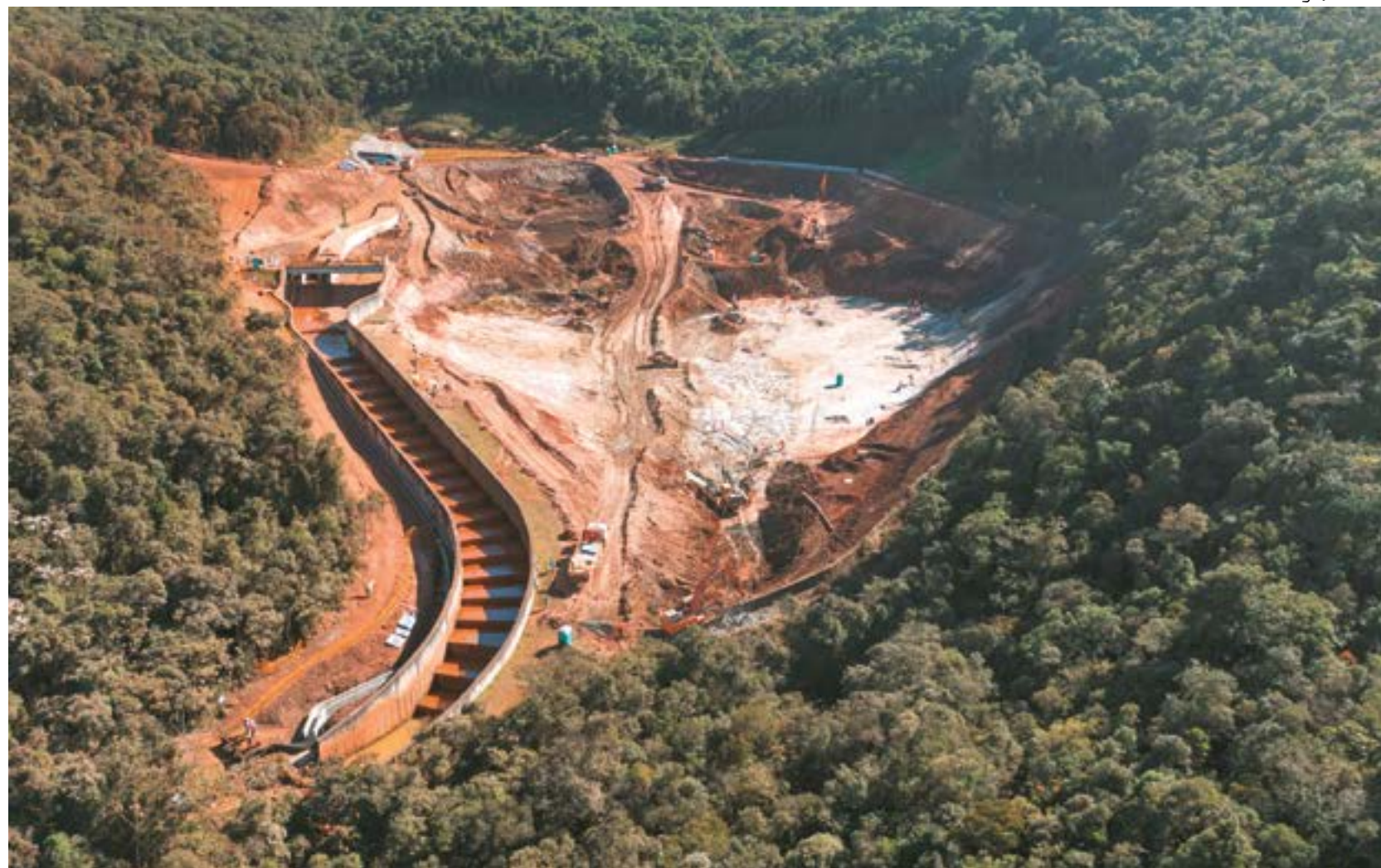
Barragem Baixo João Pereira, da mineradora Vale
