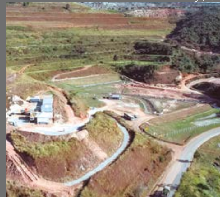
Barragem Ipoema, nas Minas do Meio, em Itabira
