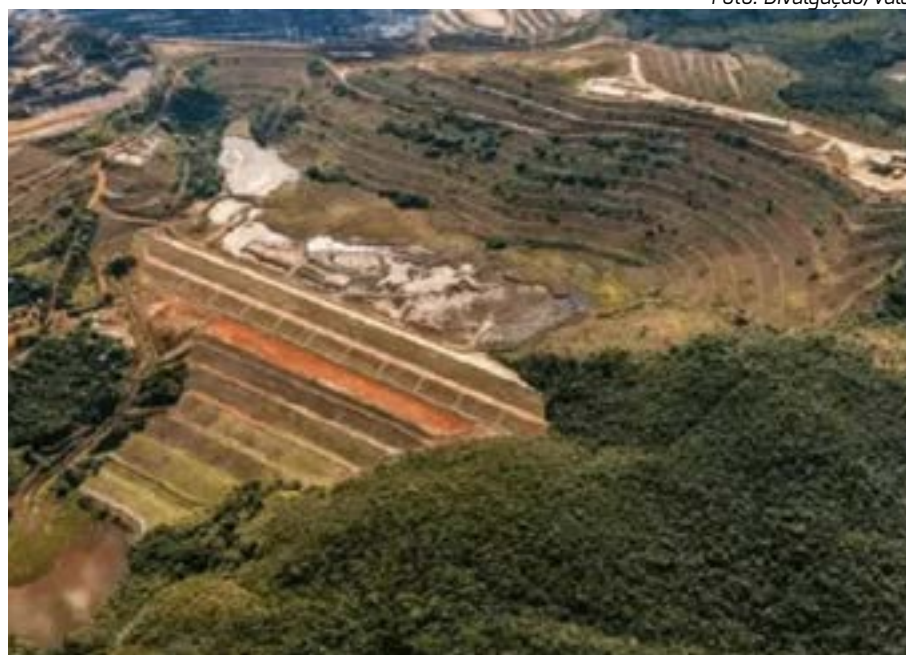
Barragem Sul Superior da mina Gongo Soco, em Barão de Cocais
