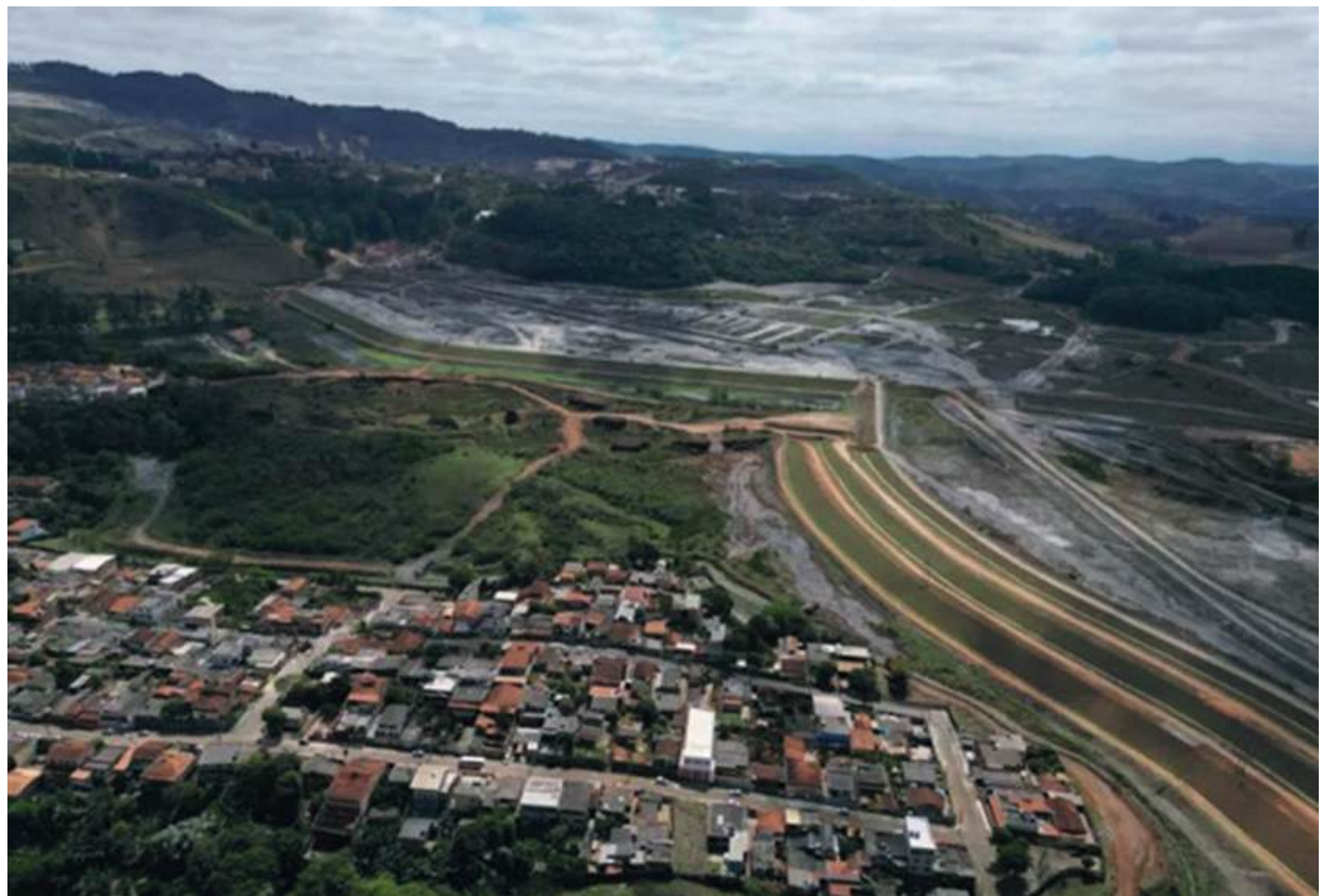
A cidade de Itabira conta com diversas barragens e diques com rejeitos da mineração
