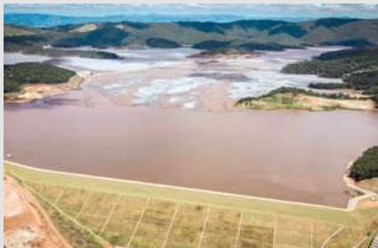
Foto: Esdras Vinícius (Barragem Itabiruçu)
